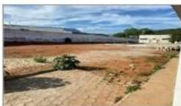
Construção da quadra.
