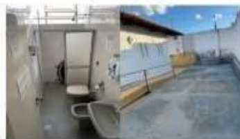
Banheiro e acesso antigo.
