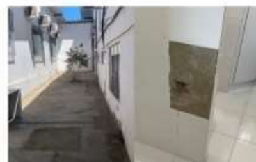
Pátio entre os pavilhões e parede do novo banheiro dos professores.
