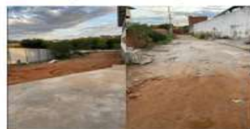
Área externa da creche, com mato e entulho.
