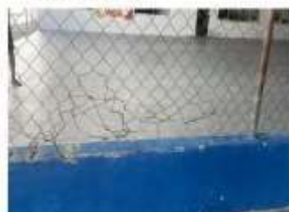
Alambrado da quadra.
