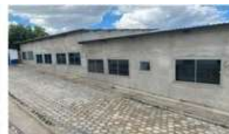
Núcleo de formação em construção.
