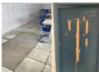
Piso e porta de sala de aula.
