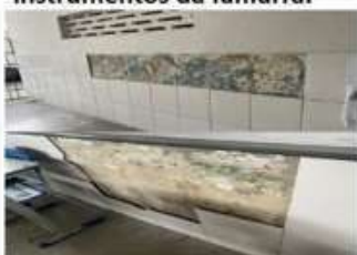
Parede de sala e pátio.
