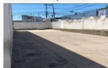
Pátio ao lado do refeitório.
