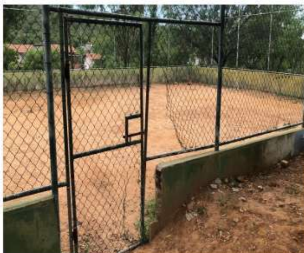
Foto 115 – Alambrado da quadra
