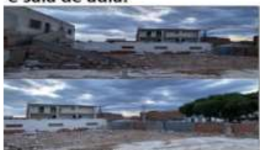
Casas compradas para ampliação.
