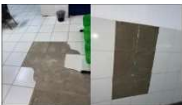
Piso e parede de sala.
