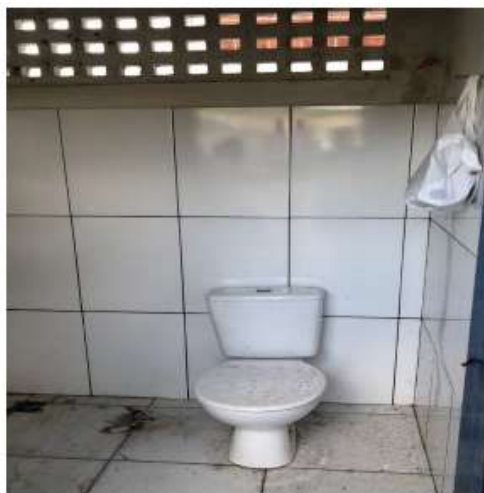
Fotos 30, 31, 32 e 33 - Banheiros
