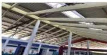
Estrutura não usada do telhado.
