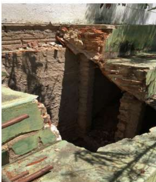
Foto 47 – Sapata para construção da cobertura.
