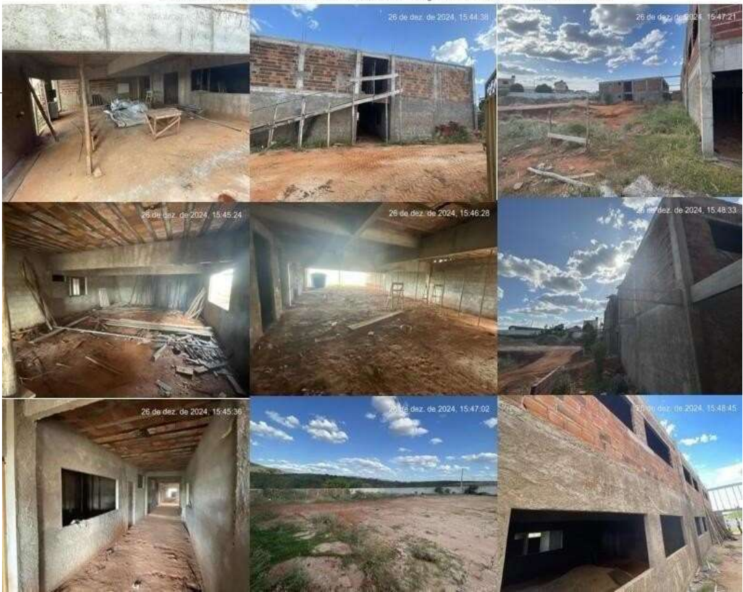
ESCOLA ANA RODRIGA-CONTRUÇÃO DA NOVA ESCOLA
