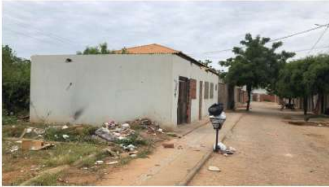
Foto 120 - Centro comunitário do Conjunto Habitacional Brisas.
