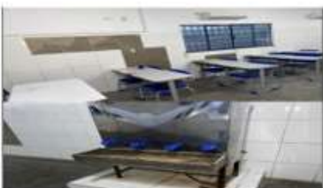
Parede da sala e bebedouro.
