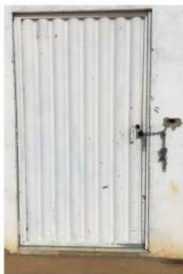
Foto 17 – Porta do Vestiário
