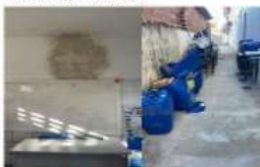
Parede de uma sala e corredor no fundo das salas.
