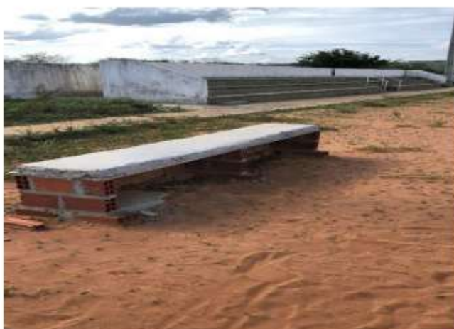
Foto 13 – Banco de alvenaria
