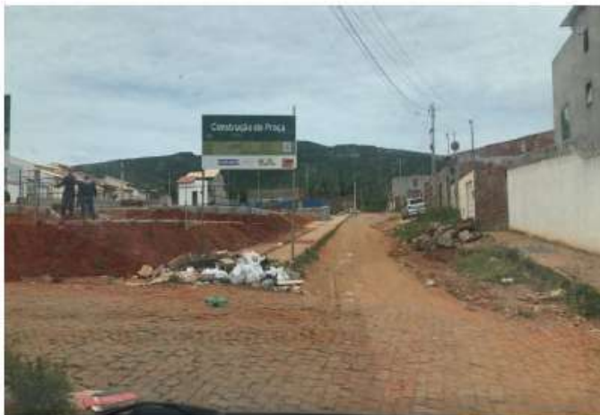
Foto 163 - Construção da Praça – Olhos D'Água
